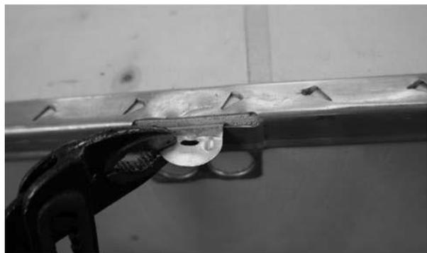
Fig. 4 Ouverture des fixations
