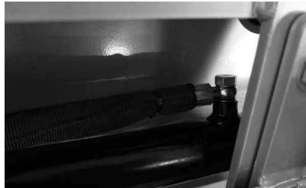
Fig. 17 Hydraulische leiding, rechts
