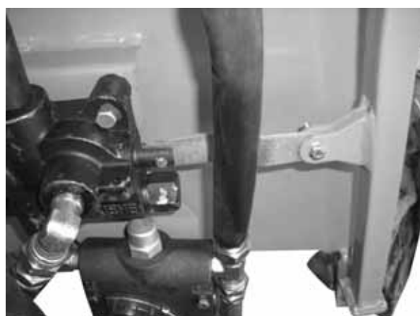
Aansluiten van de regelklep
