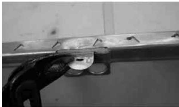
Fig. 4 Ouverture des fixations
